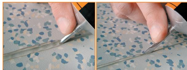
Для шов с небольшим зазором используйте приложенную алюминиевую насадку. Перед использованием насадки удалите из нее пластиковую вставку: вставка предназначена для очистки насадки после окончания работ. В зависимости от ширины зазора и толщины напольного покрытия время затвердевания составляет от 2 до 12 часов. Если зазор после высыхания не полностью заполнен, повторите процесс примерно через 2 часа.
