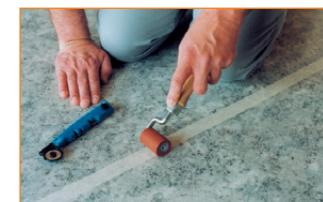
Разрежьте скотч в зоне шва ножом с круглым лезвием. Также можно использовать ножи с трапециевидным или крючкообразным лезвием. Важно: чтобы не повредить напольное ПВХ-покрытие, при прорезании скотча глубоко вдавите нож в шов. В случае, если напольное ПВХ-покрытие не достаточно эластичное (например, полукоммерческое напольное ПВХ-покрытие), рекомендуется нагреть область шва феном или утюгом (не более 40 °C).
