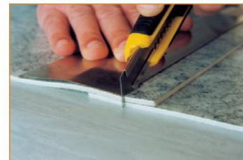
Разрежьте полосы напольного покрытия, уложенные внахлест (3–5 см), с помощью ножа и металлической линейки/планки (метод резки внахлест).
