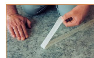
Примерно через 60 минут, когда средство для холодной сварки на поверхности скотча высохнет, снимите скотч, потянув его под острым углом назад.
